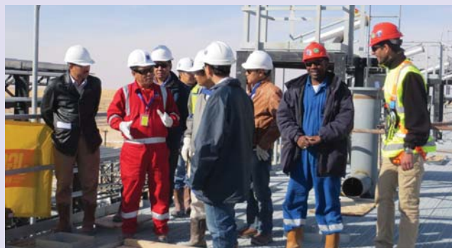
Lãnh đạo PVEP trực tiếp kiểm tra tiến độ xây dựng hệ thống kết cấu trung tâm và chỉ đạo kỹ thuật. Ảnh: PVEP
