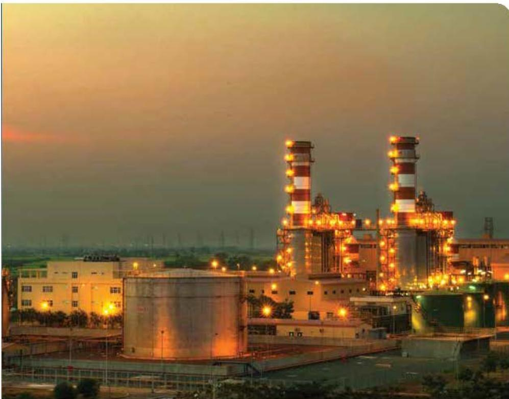
Công ty Cổ phần Điện lực Dầu khí Nhơn Trạch 2 (PV Power NT2) là chủ đầu tư thực hiện xây dựng và quản lý vận hành khai thác Dự án Nhà máy Điện Nhơn Trạch 2. Nhà máy sử dụng công nghệ turbine khí chu trình hỗn hợp thế hệ F với cấu hình 2-2-1, bao gồm 2 turbine khí, 2 lò thu hồi nhiệt và 1 turbine hơi, tổng công suất đạt 750MW với sản lượng điện trung bình trên 4 tỷ kWh/năm. Nguồn nhiên liệu khí cho nhà máy được khai thác từ bể Cửu Long và Nam Côn Sơn.
