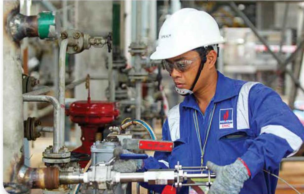
Kỹ sư DMC lắp đặt hệ thống đo ăn mòn tại Nhà máy lọc dầu Dung Quất
