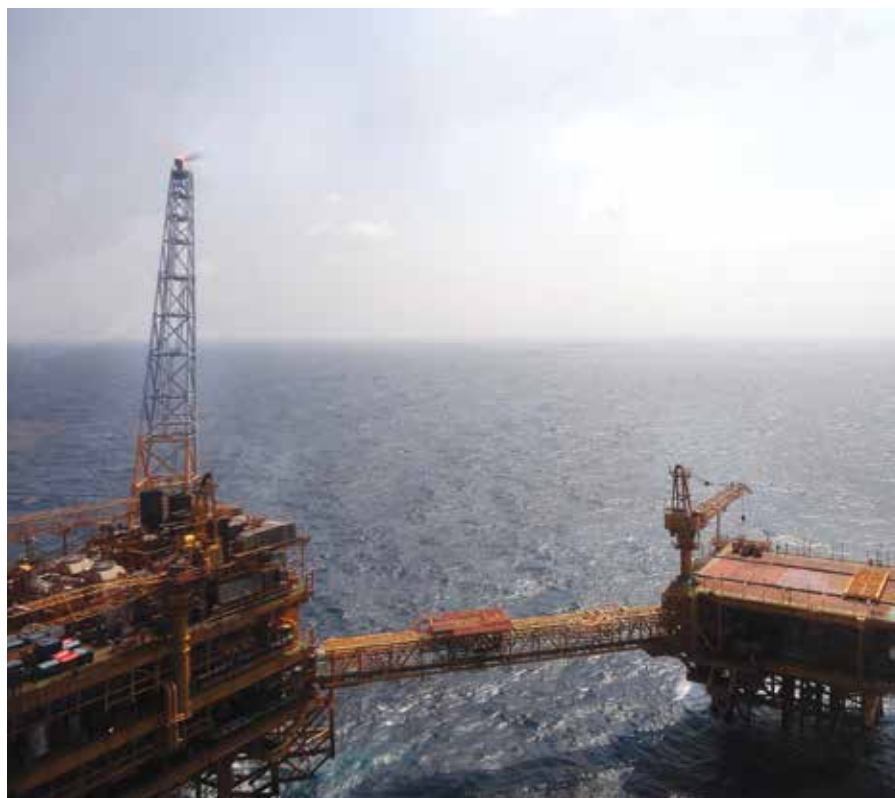
Giàn đầu giếng Hải Thạch được kết nối với giàn xử lý trung tâm Hải Thạch. Ảnh: Phan Ngọc Trung
