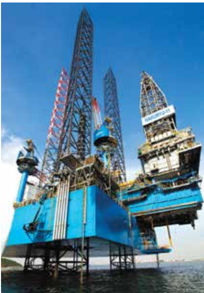
Giàn khoan biển tự nâng Hakuryu-11. Nguồn: JDC
