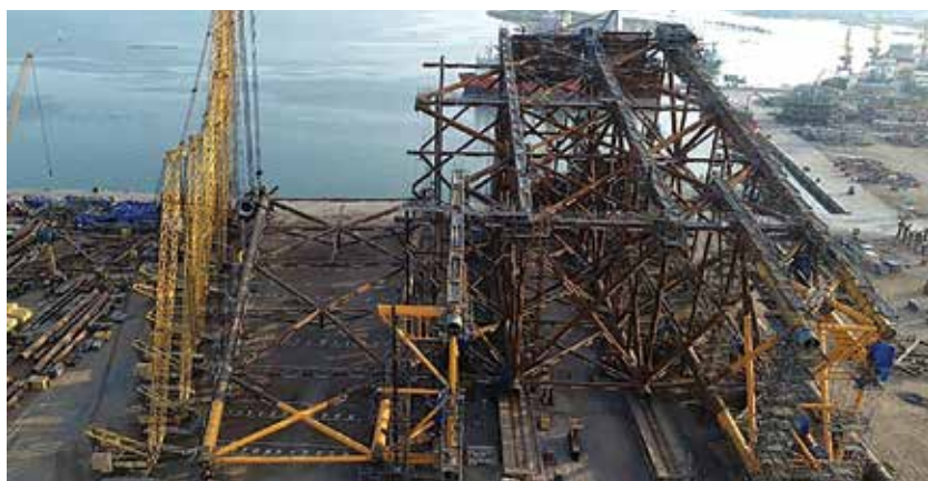
Chân đế Sao Vàng được lắp dựng tại Cảng Vietsovetro. Ảnh: VSP
