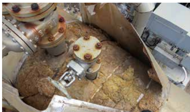
Hình 12. Phương pháp kiểm tra trực quan ăn mòn dưới lớp bảo ôn
