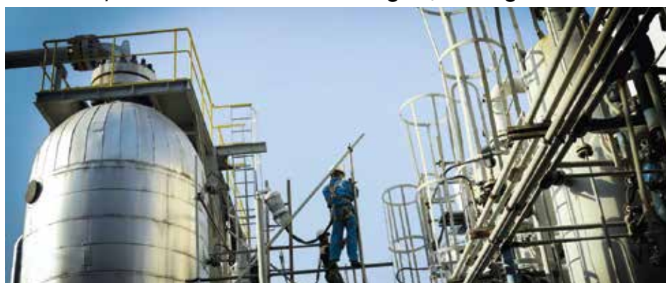
KVT tiến hành bảo dưỡng sửa chữa hệ thống chế biến khí tại Nhà máy Xử lý khí Dinh Cố. Ảnh: PV GAS
